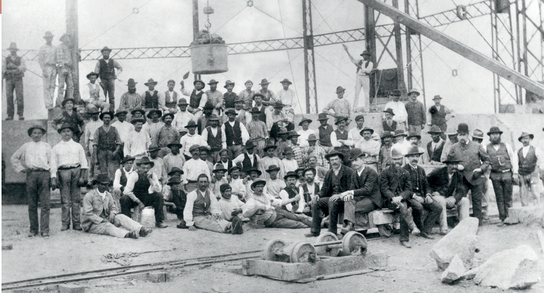
Trabalhadores da construção do Gasômetro nº1 na Rua da Figueira, Brás. Fotografia, autor desconhecido, 1890. Acervo Fundação Energia e Saneamento.
