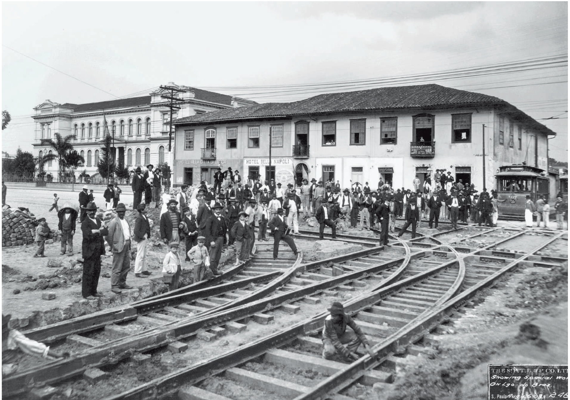
Obras do cruzamento de linhas no Largo do Brás, na avenida Rangel Pestana, esquina das ruas Piratininga e Jairo Goes, antiga Travessa do Brás. Ao fundo, Grupo Escolar do Brás. Fotografia, Guilherme Gaensly, 1900. Acervo Fundação Energia e Saneamento.
