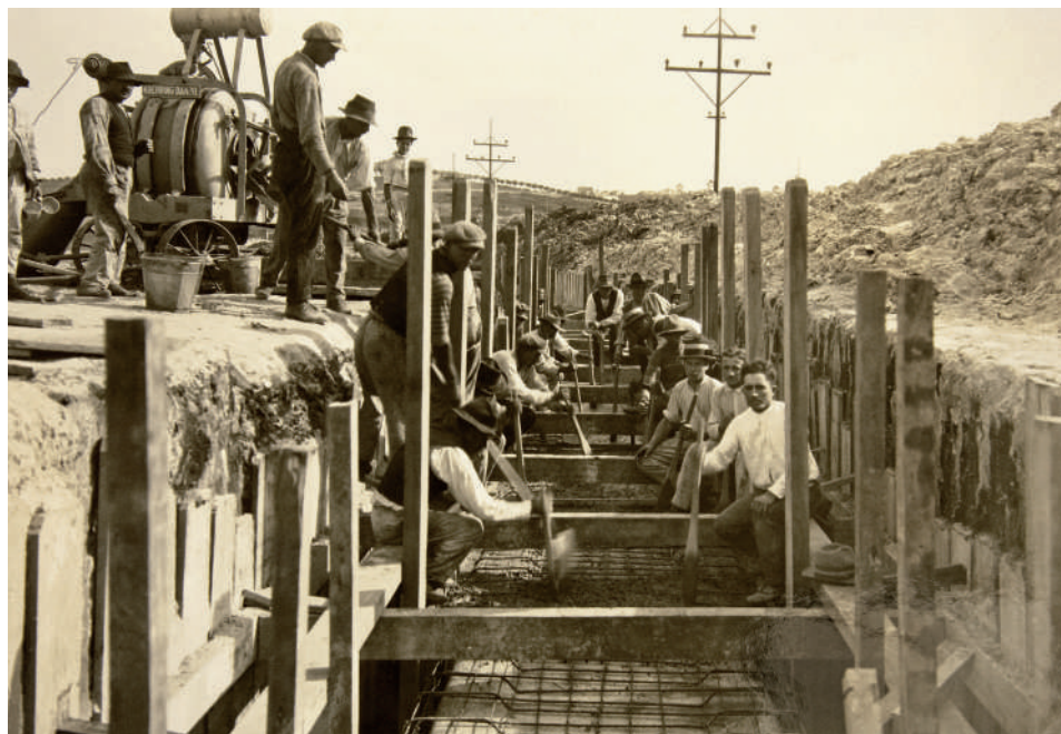
Águas pluviais - Galeria Borges Figueiredo. Fotografia, Comissão das Obras de Saneamento da Capital, 21/05/1927.
