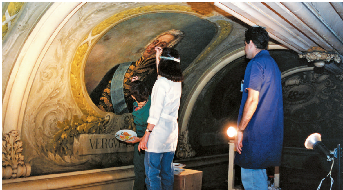
Restauradores em atividade na sanca. Fotografia, José Rosael, Anos 1990.
