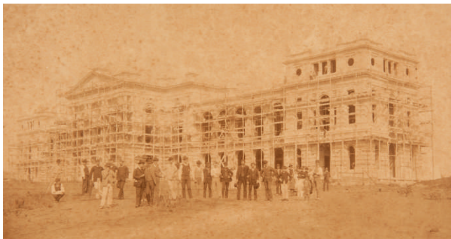
Edifício-monumento do Ipiranga em construção, com andaimes e pessoas à frente. Fotografia, autor desconhecido, 1888.
