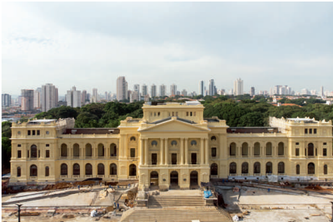
Museu do Ipiranga em obras. Fotografia de drone, Pedro Catunda Marques, 2022.
