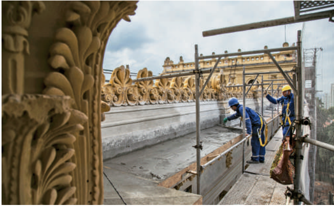
Processo de restauro do telhado do edifício. Fotografia, Helió Nobre, 2020.
