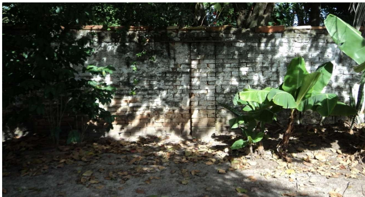
Rua Joaquim Bernardes Borges, 72 – Centro – Itu/SP: canteiro
